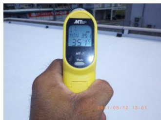
アドグリーンコート塗装施工完了後
